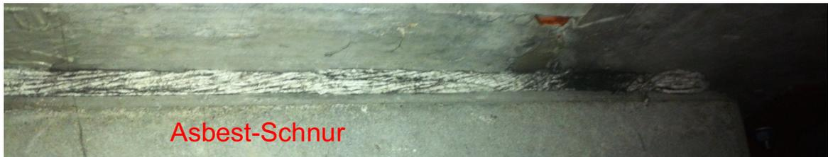
**Vorsichtige, erschütterungsfreie Kontroll-, bzw. Instandhaltungstätigkeiten**, welche die Mauerkronen bzw. Bauteile mit Asbest nicht tangieren, sind unter Einhaltung von Vorsichtsmassnahmen möglich.
